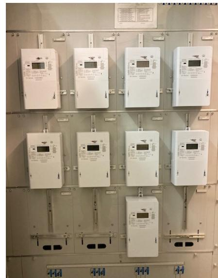
Abbildung 41: Zähleranlage auf Hauptverteilung in Untergeschoss, DC Zuleitung über Steigzone unmittelbar darüber möglich.
