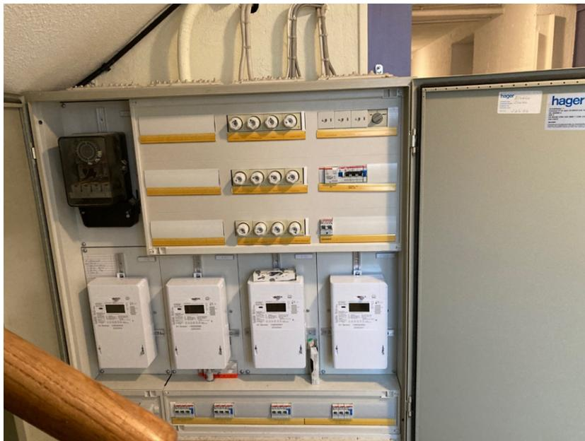
Abbildung 19: Hauptverteilung im Untergeschoss mit elektronischen Zählern
