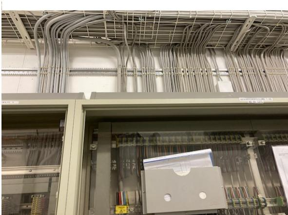
Abbildung 59: Steigzone für DC Leitungen ab oberhalb der Hauptverteilung bis Unterkante Dach
