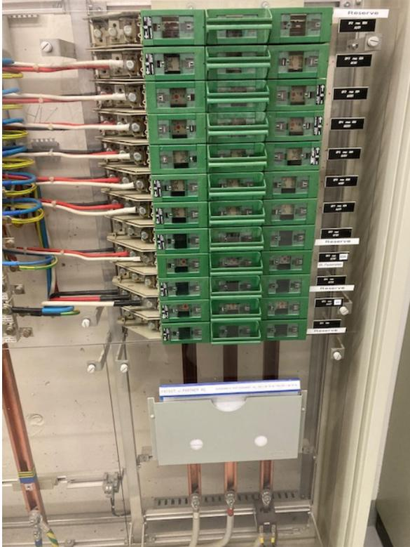
Abbildung 58: In Hauptverteilung im UG genug Platz für Überstromunterbrecher und Platz für Wechselrichter in Nebenräumen UG genügend
