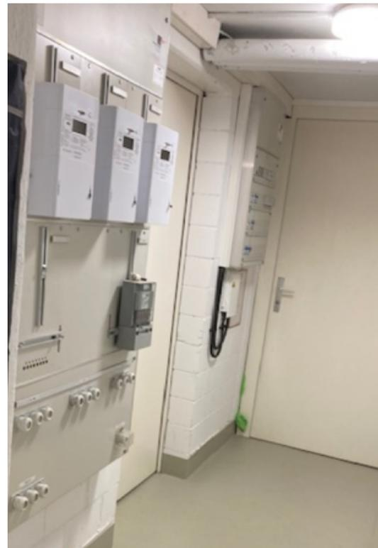
Abbildung 31: Hauptverteilung (links) mit elektronischen Zählern im Untergeschoss, Unterverteilung (rechts).
