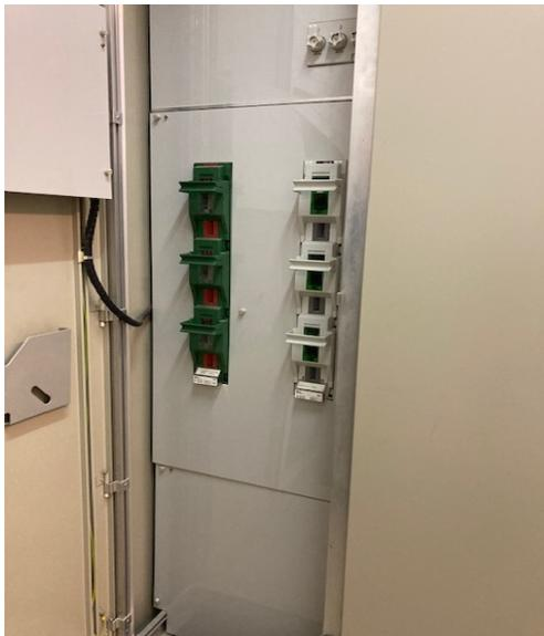
Abbildung 42: Anschlussüberstromunterbrecher mit 250A, genügend
