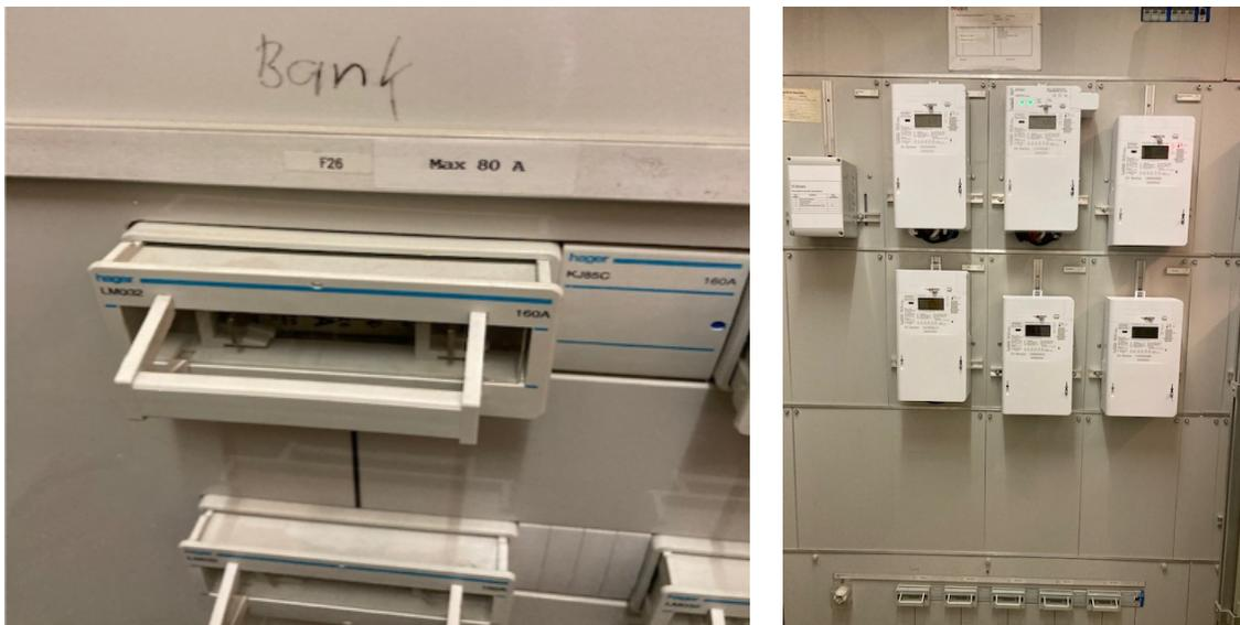
Abbildung 50: Der Überstromunterbrecher (links) für die Unterverteilung der Bank ist genügend für eine PV-Anlage auf dem Dach der Zentrumstrasse 2. Die Zähleranlage auf Hauptverteilung (rechts), die DC Zuleitung ist über Steigzone unmittelbar über Hauptverteilung möglich.
