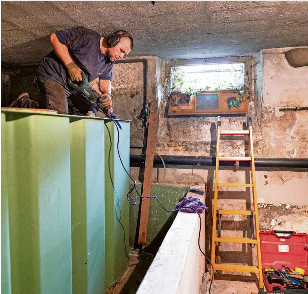
Der gewünschte Ersatz: Ein Heizungsinstallateur demontiert einen Öltank im Keller eines Hauses, um die alte Ölheizung durch eine Wärmepumpe mit Erdsonde zu ersetzen.
