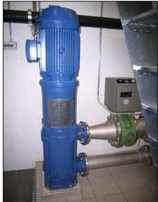
Abbildung 4: Rückwärtslaufende Kreiselpumpe (Häny, 2010)
