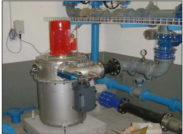
Abbildung 6: Gegendruckpeltonturbine (Häny, 2010)
