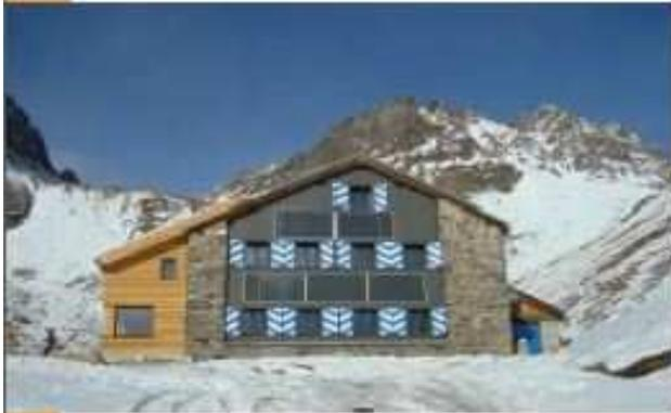
**Bei den Luftkollektorpaketen TWINSOLAR Compact sind die wichtigsten Technikkomponenten wie Ventilator und Photovoltaikmodul im Kollektor integriert.**
