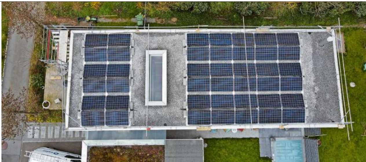
Erneuerbare Energie: Eine Solaranlage wird im Rahmen des PV-Sorglospakets der Energieallianz Linth installiert.
